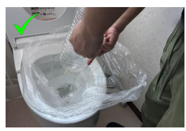
汚水の逆流を防ぐ水嚢作り
